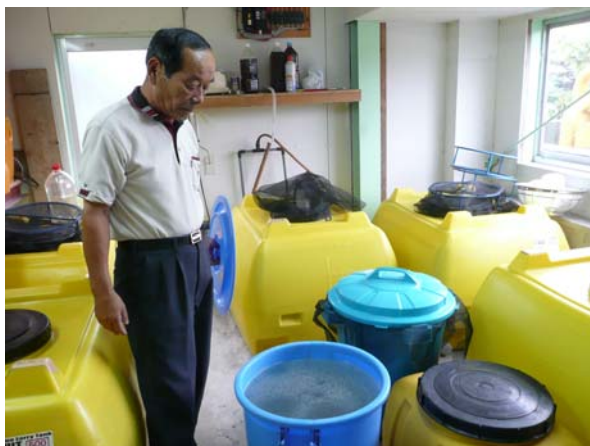
完成前の商品を貯蔵しているタンク室
